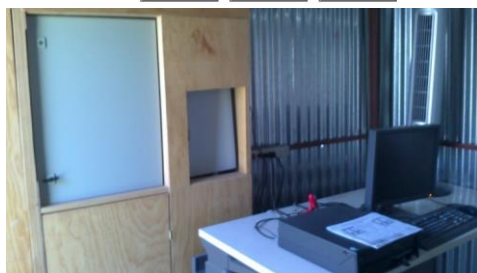
Fig. 11. Panel de control y caseta de control.
